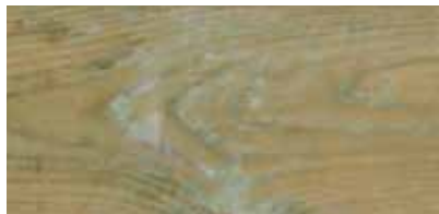
Residui del trattamento in autoclave
